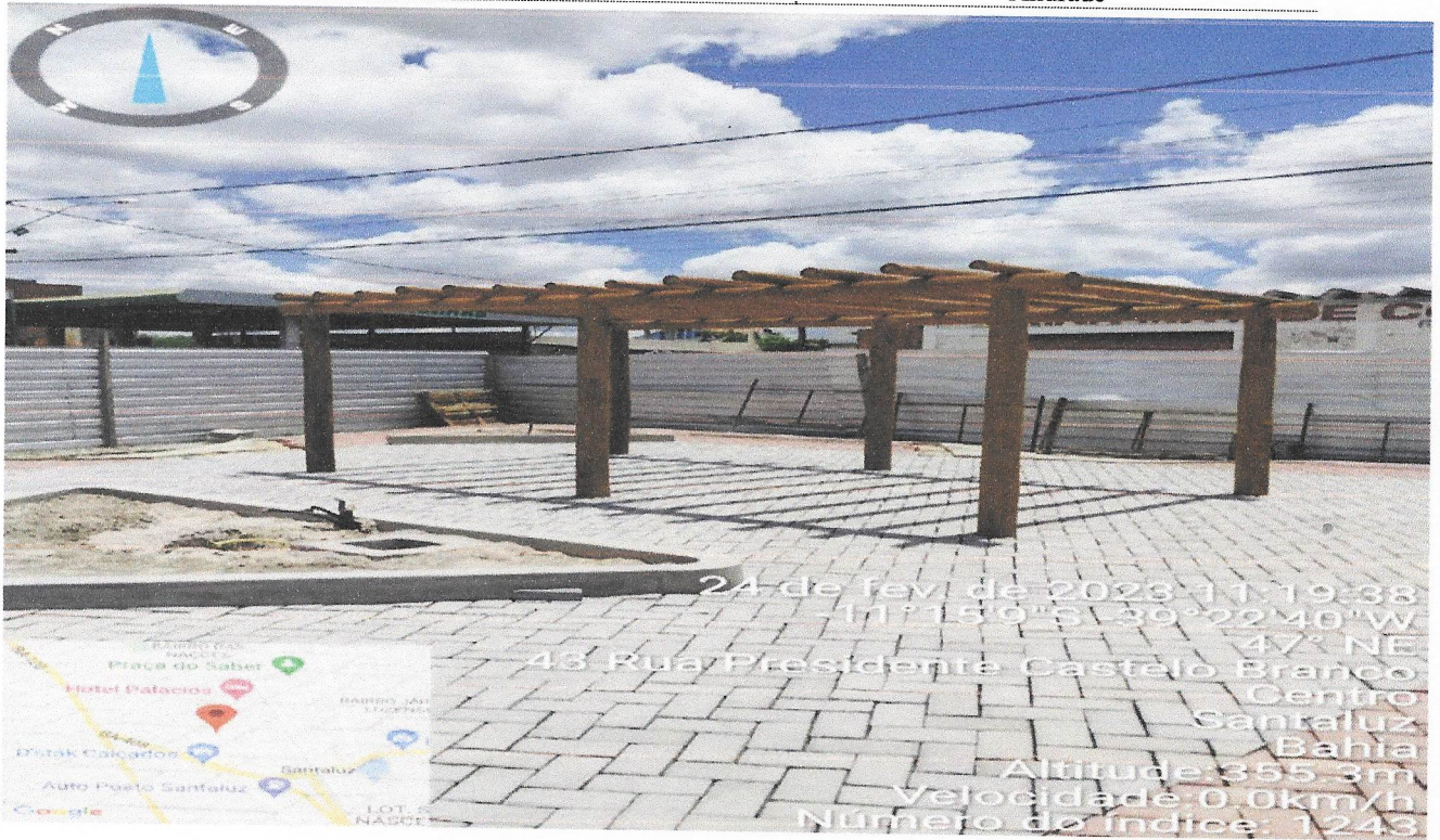
Foto 11 – Execução de Pergolado.
