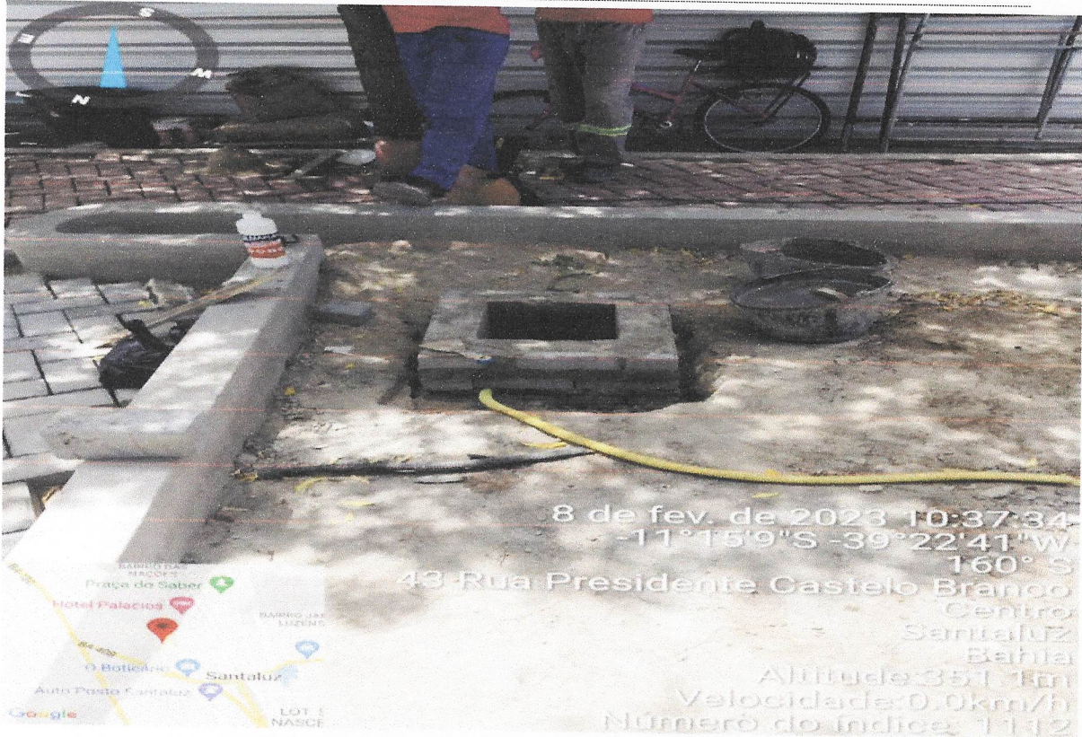
Foto 15 – Execução das Caixas de Passagem.
