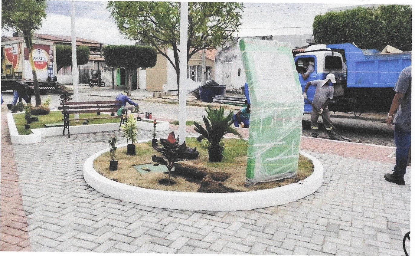
Foto 09 – Execução de Pintura.
