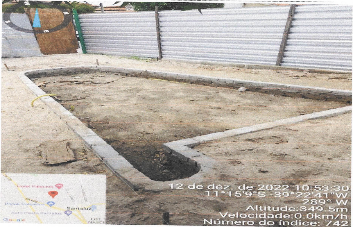
Foto 07 – Execução de Alvearia de Vedação.
