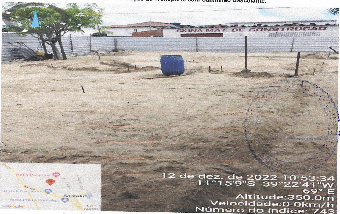
Foto 06 – Execução de Aterro Manual com Solo Argilo-Arenoso
