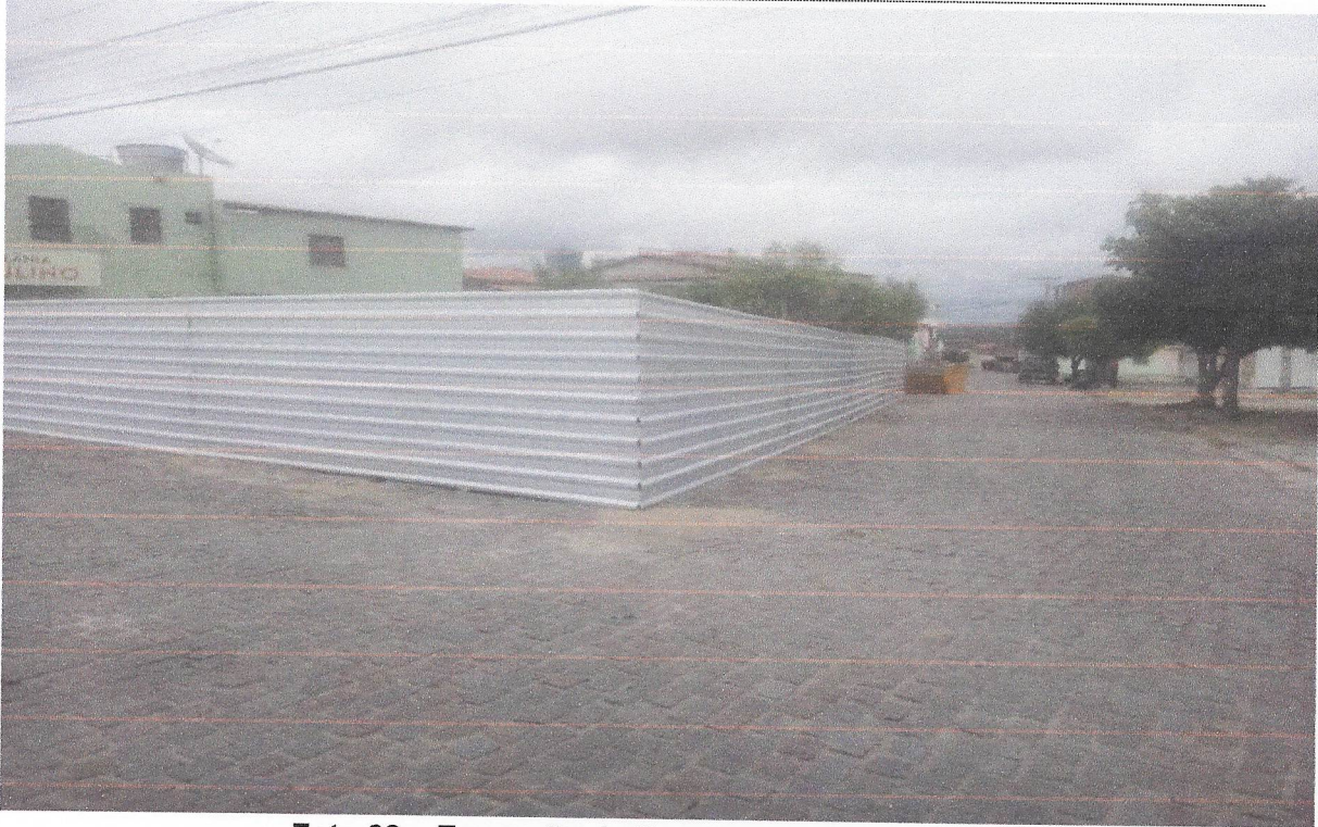
Foto 03 – Execução de Tapume com Telha Metálica.
