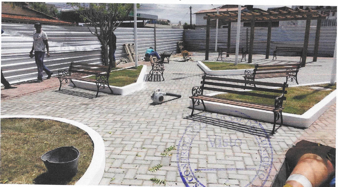
Foto 10 – Execução de instalação dos Bancos.
