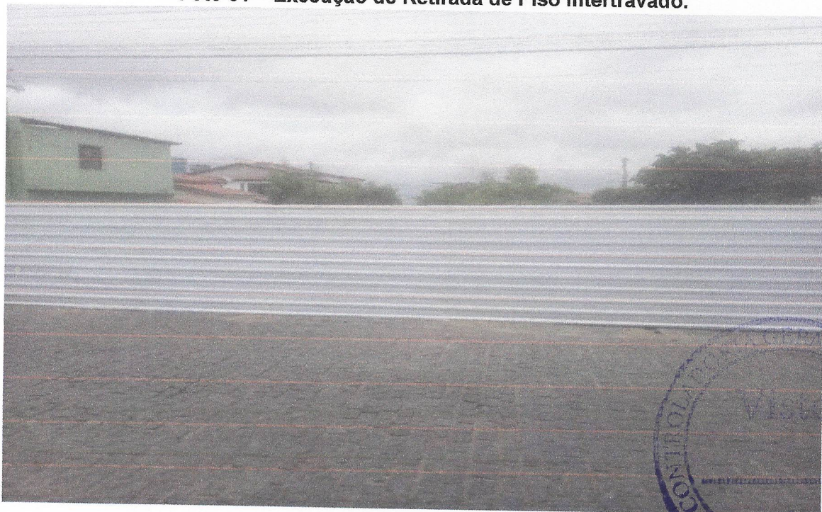
Foto 02 – Execução de Tapume com Telha Metálica.
